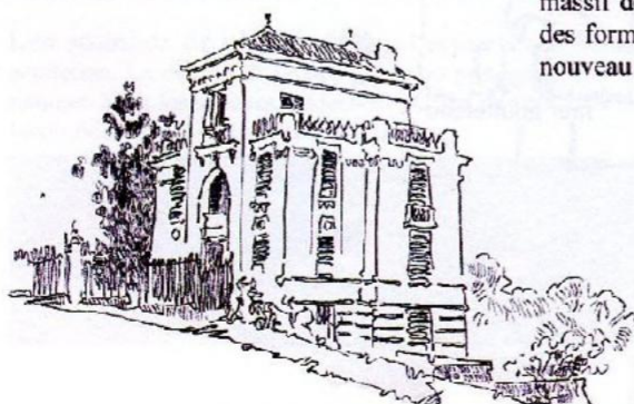
Toiture à croupes sur avant-corps central toits terrasses sur les ailes - Sainte Marie Sicché
