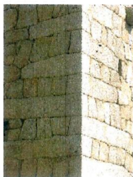
Guarguagule – Ancienne maison forte – Détail d'une chaîne d'angle. Les parements montrent des pierres taillées, assemblées à joint vif, soigneusement ajustées selon leur forme. Les pierres posées à plats dont les bouts sont visibles suggèrent l'épaisseur des murs. La mise en œuvre exprime la solidité de la construction en rapport avec sa fonction.
