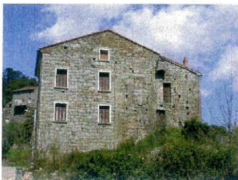
Grosseto Prugna- Les chaînes d'angle de la construction d'origine permettent d'en lire le contour. Les parements de l'ajout présentent des pierres assemblées selon des lits quasi horizontaux composés de blocs de dimensions semblables y compris aux angles.
